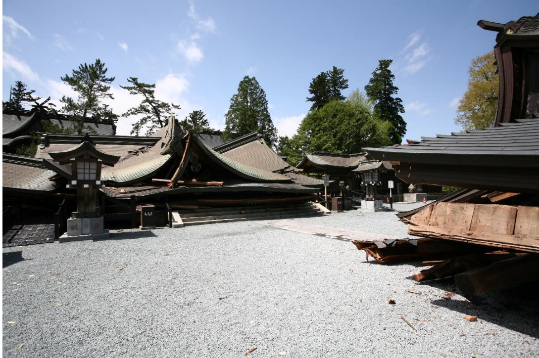
熊本地震直後〈平成28年4月16日〉全壊した拜殿（正面）と楼門（右）
