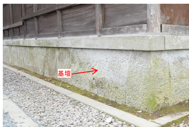
拝殿周り 基壇 昭和 23 年に竣工した建物群の基礎になります。
