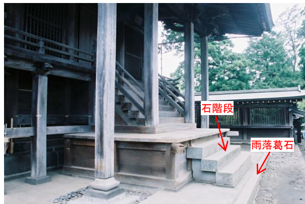
三の神殿 正面 神殿 3 棟の石階段と三の神殿の雨落葛石の一部にも同じ種類の石材が使われています。
