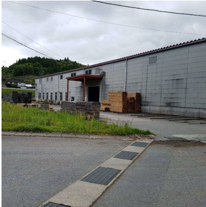
* 県産材置場(阿蘇森林組合 清和工場) 倉庫外観
