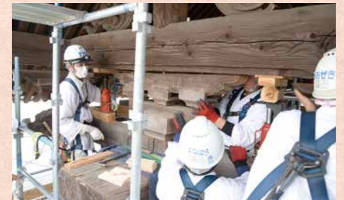
親柱上の組物が破損していました。元の位置に注意して番付札を打って取り外しました。割裂した箇所へ接着剤を注入するなど慎重に補修し、震災前の姿に戻っていました。
