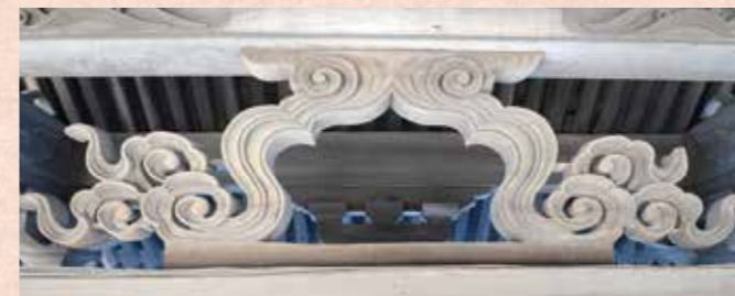
墓股は地震で割れて防鳥ネットの上に落下していました。割れたところに太枘を仕込んで接着剤で接合しました。
