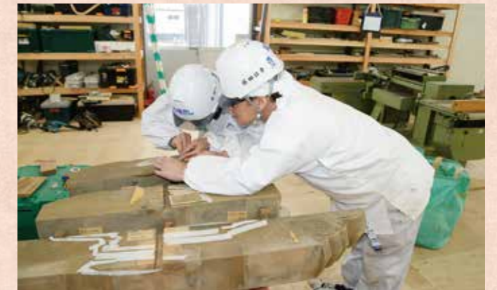
墓股は地震で割れて防鳥ネットの上に落下していました。割れたところに太枘を仕込んで接着剤で接合しました。
