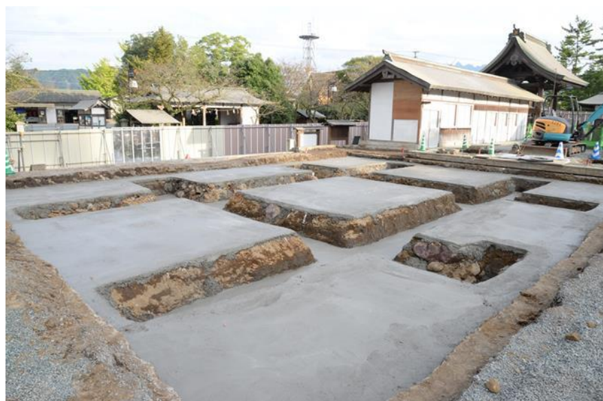
素屋根基礎設置箇所の掘削
