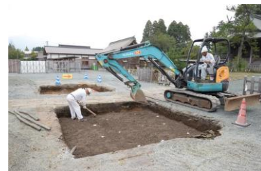
素屋根基礎設置箇所の掘削
