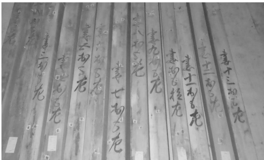
楼門上層 妻面地垂木 上面
