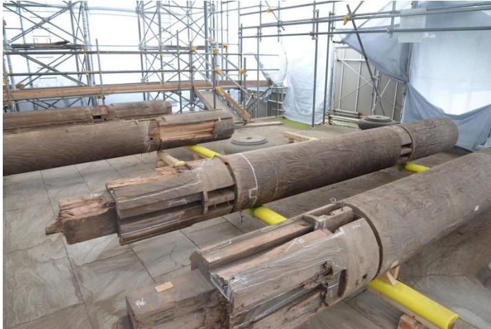
左上：調査後の部材（楼門 1階柱）
