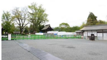
↑ 解体後の写真です
