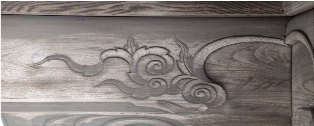
二の神殿向拝格天井 南北面虹梁内側
