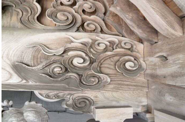
二の神殿唐破風 虹梁 (格天井東面虹梁 外側)
