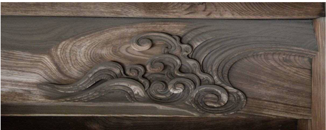
二の神殿向拝格天井 西面虹梁
