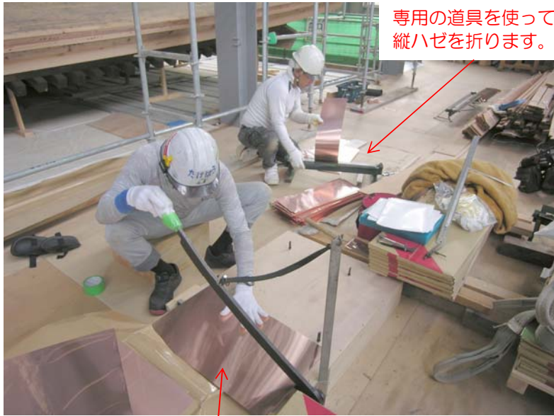
定尺の銅板を正確に4枚に切断しました。
