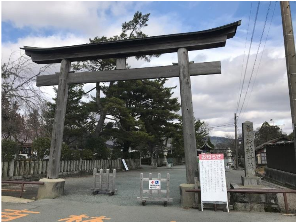
旧南鳥居 解体前の様子（平成30年12月）
