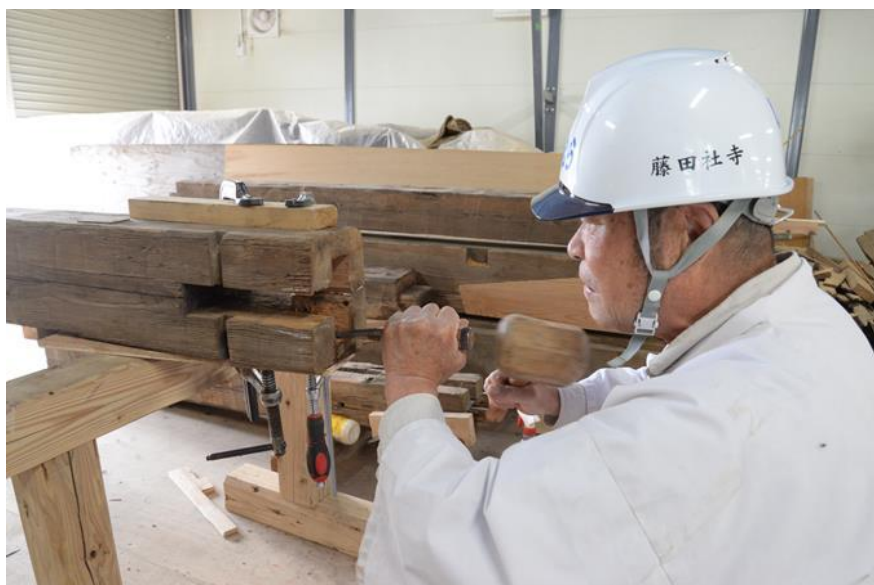
折れて新材に置き換えた部分
