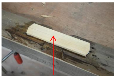
折れて新材に置き換えた部分
