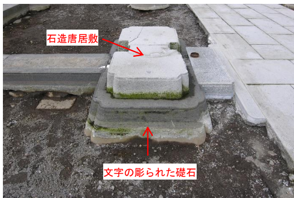
楼門 文字の彫られた礎石（解体中の写真） 石造唐居敷が載っている箇所に彫られていました。
