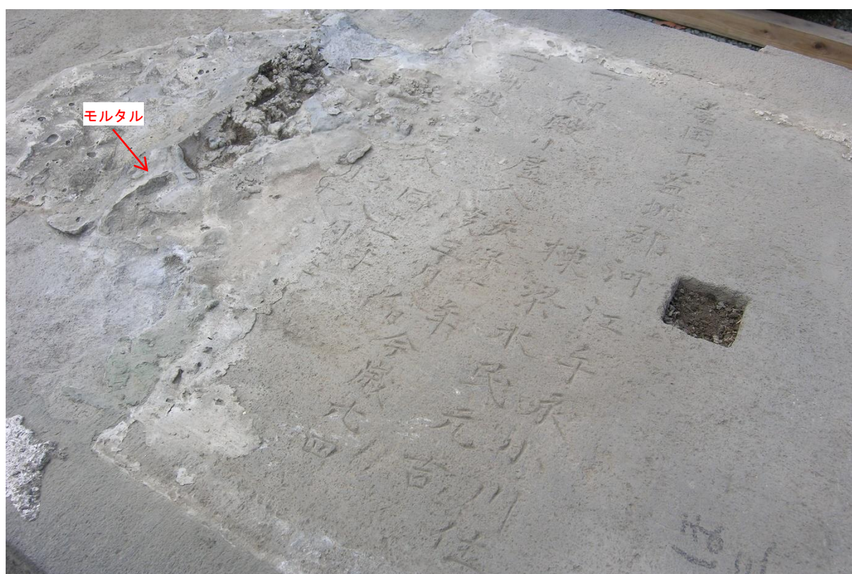
楼門 文字の彫られた礎石（解体中の写真） 石造唐居敷が載っている箇所に彫られていました。
