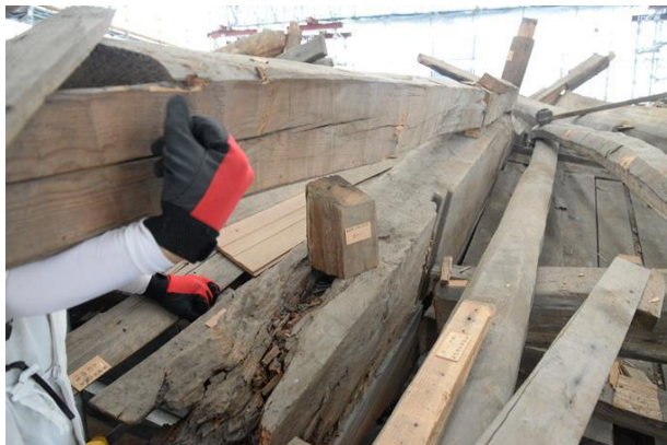
大工さんに持ち上げてもらい、縦材と横材の取付きを撮影
