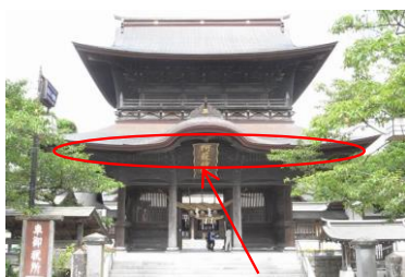
この部分の部材です
