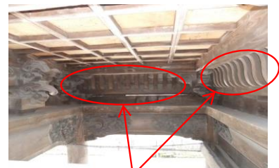
この部分の部材です
