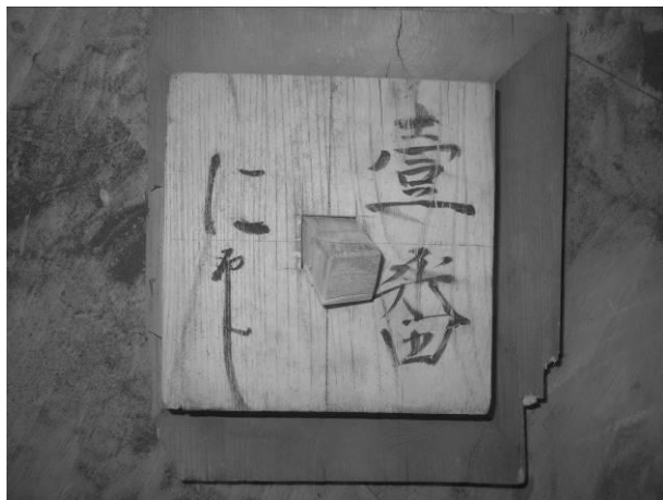
楼門上層 巻斗下面
