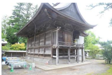
↑足場解体後の写真です
