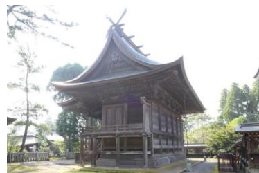
↑足場設置前の写真です
